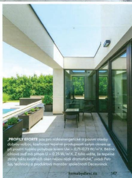
**PROFILY EFORTE** jsou pro nízkenergetické a pasivní stavby dobrou volbou, koeficient tepelné prostupnosti celým oknem se při použití třápkla polybutyle kolem U<sub>w</sub> = 0,71-0,73 W/m<sup>2</sup>K. Bežná cihlová zed má přitom U = 0,25 W/m<sup>2</sup>K. Z toho vidíte, že tepelné ztráty takto kvalitních oken nejsou nijak dramatické,“ uvádí Petr Šys, technický a produktový manažer společnosti Deceuninck.
